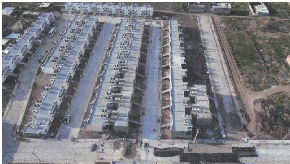
Foto 1. Vista área del fraccionamiento El Guayabo II. Fecha: 23.junio.26
