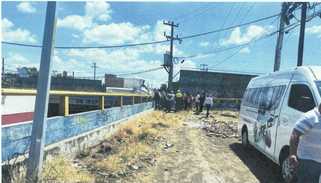
Fotografía. Paso deprimido Av. Álvaro Obregón
