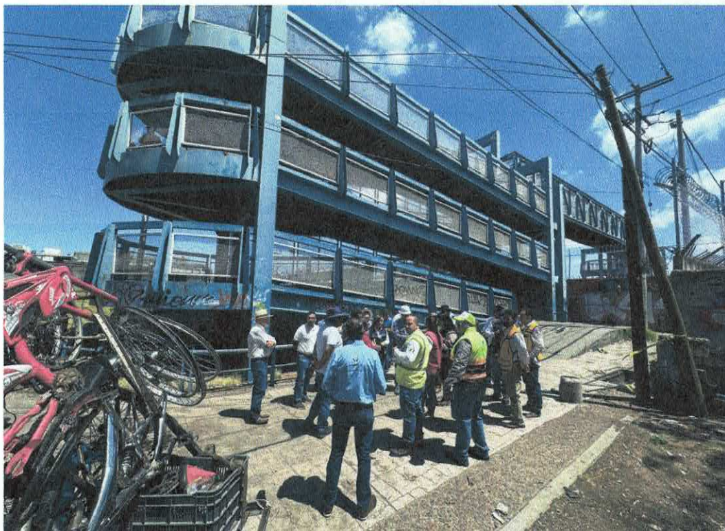
Fotografía. Puente peatonal en Lerdo de Tejada
