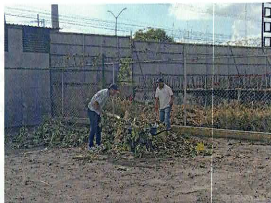
| Ilustración 67.- Limpieza de barda perimetral del estacionamiento. Febrero 2026.
