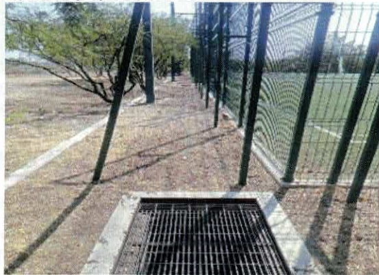
| Ilustración 65.- Colocación de rejas en bocas de tormenta en la periferia de la cancha de futbol uruguayo. Febrero 2026
