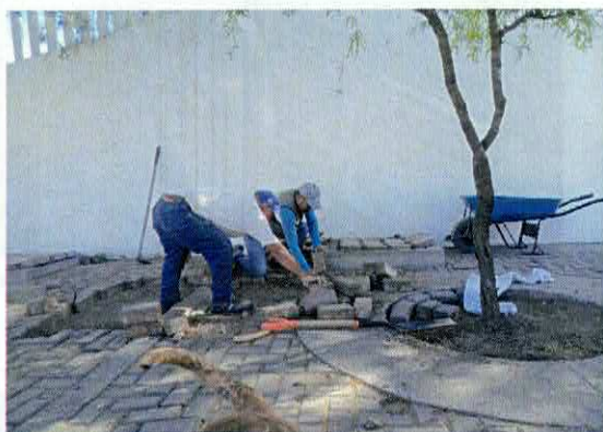
| Ilustración 68.- Reacomodo de adoquines en entrada principal para facilitar el acceso al Parque. Marzo 2026.
