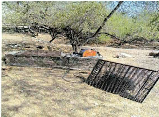
| Ilustración 65.- Colocación de rejas en bocas de tormenta en la periferia de la cancha de futbol uruguayo. Febrero 2026
