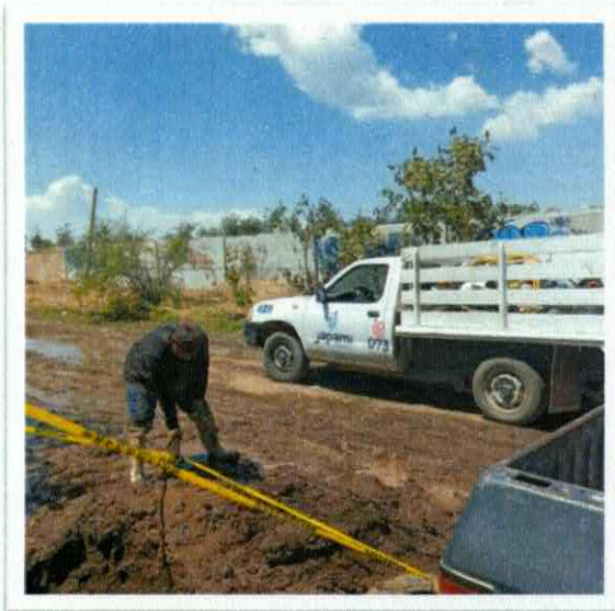
Reparación de Fuga Colonia Plan Vivirá, 22/03/2026
