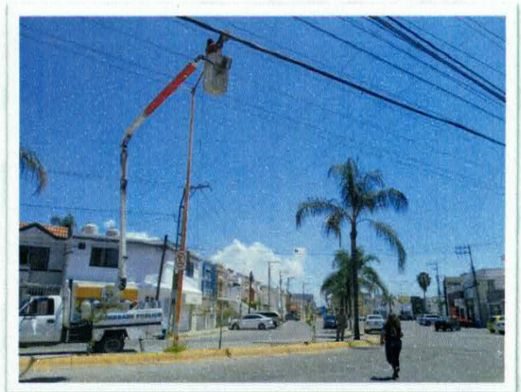
Fotografía 21.- Cambio de Luminaria, Frac Quinta Villas, 24/03/2026
