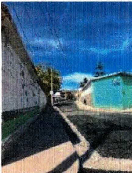
Supervisión de obra alumbrado público 28 de Enero Cuchicuato
