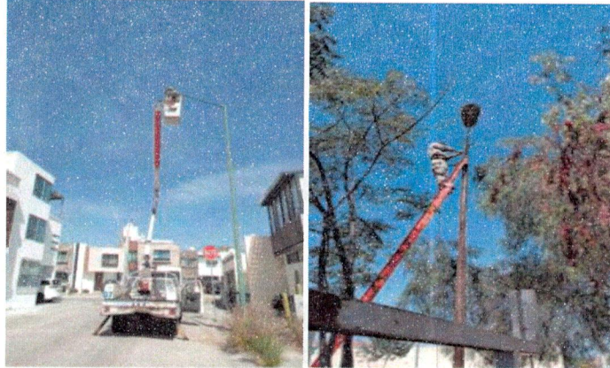
Figura 38, Mantenimiento Preventivo y correctivo del Alumbrado Público Fuente: Informe enero-marzo de la DAP
