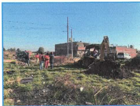
Foto 29. Arranque de trabajos de estudio geofísico geotécnico. Fecha: 13.feb.26
