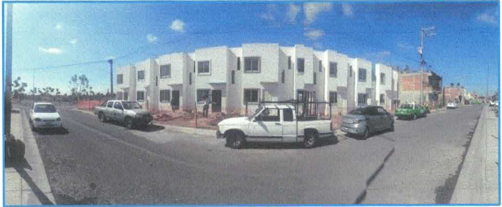
Foto 01. Vista panorámica de las 10 viviendas. Fecha: 27.mar.26
