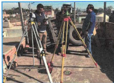
Foto 23. Replanteo Poligonal Expo Fresas. Fecha: 26.ene.26
