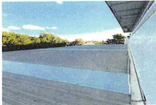
Impermeabilizante del techo del área de Gimnasia, TKD y Box (cambio lámina traslucida) Módulo COMUDAJ.
