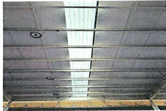
Impermeabilizante del techo del área de Gimnasia, TKD y Box (cambio lámina traslucida) Módulo COMUDAJ.
