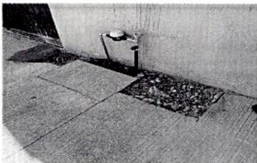
OBRA_45_JAPAMI-LS-RP-OP-2025-43 Suministro e instalación de micromedidores para cambio de cuota fija a servicio medido.
