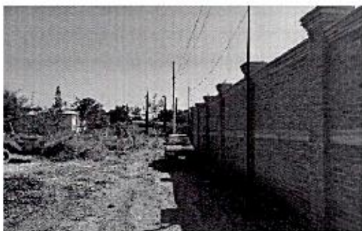
OBRA_3_DGOP-SENCO-AD-PU-SG-2025-059 Ampliación de red de electrificación en el municipio de Irapuato, Gto., en la localidad Irapuato, en las calles Privada Sin Nombre, camino a Vista Alegre.
