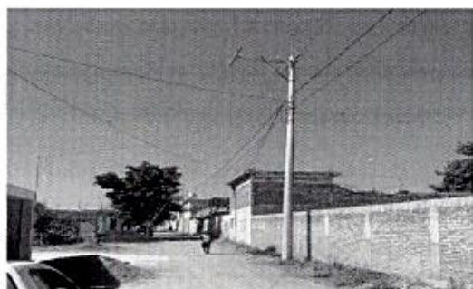
OBRA_23_DGOF-SENCO-AD-PU-SG-2025-067 Ampliación de red de electrificación en el municipio de Irapuato, Gto., en la localidad de Santa Elena de la Cruz en la calle 12 de Diciembre.
