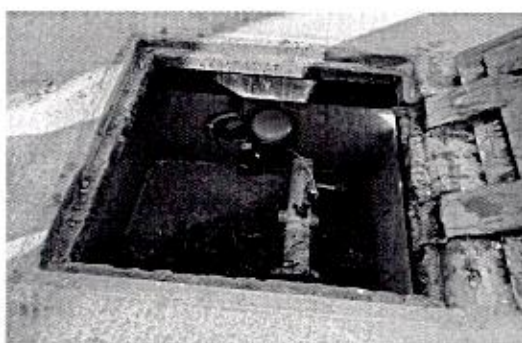
OBRA_47_JAPAMI-LPN-PROAGUA-2025-39 Obras de Sectorización en la ciudad de Irapuato, Gto. (2da. Etapa).
