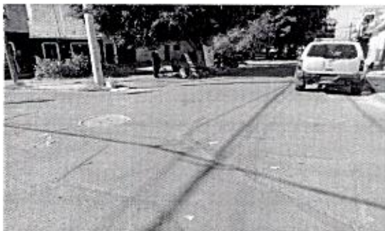
OBRA_41_JAPAMI-AD-RP-OP-2025-04 Rehabilitación de Red de Drenaje Sanitario en la Col. Plan Guanajuato (1er etapa).
