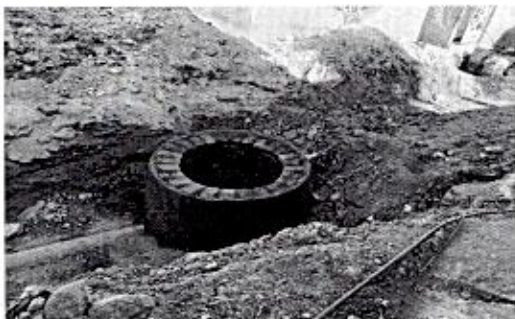
OBRA_19_DGOP-SENCO-LS-PU-SE-2025-066 Construcción de pavimentación con asfalto en el municipio de Irapuato, Gto., en la localidad Lo de Juárez, en la calle Leyes de Reforma (tramo: de calle Lázaro Cárdenas a calle Guadalupe Victoria).
