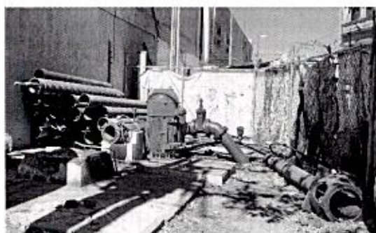
OBRA_33_JAPAMI-LS-RP-OP-2025-14 Rehabilitación de Pozos profundos de agua potable en el municipio de Irapuato, Gto. (Distrito 2) (incluye aforo) (2025)..
