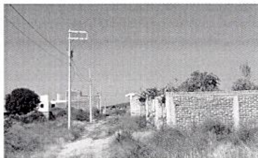
OBRA_4_DGOP-SENCO-AD-PU-SG-2025-061 Ampliación de red de electrificación en el municipio de Irapuato, Gto., en la localidad San Cristóbal, en la calle Las Palmas.
