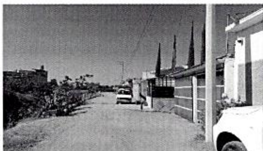
OBRA_25_DGOP-SENCO-AD-PU-SG-2025-056 Ampliación de Red de Electrificación en el municipio de Irapuato, Gto., en la localidad Irapuato, en la colonia Villareal, en la calle del Río (tramo: de Ignacio García Téllez a calle Villa de las Estrellas).
