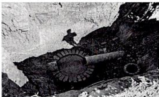
OBRA_43_JAPAMI-AD-RP-OP-2025-34 Construcción de Colector Sanitario en la calle Puerto Rico Col. Ampliación Las Américas (tramo: San Francisco de Asís a Camino Real).
