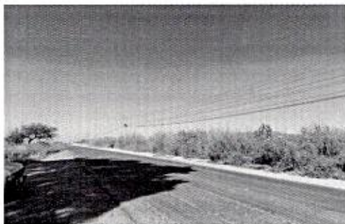
OBRA_1_DGOP-ISM-AD-PU-SE-2023-073 Construcción de alumbrado público en el municipio de Irapuato, Gto., en su tramo: KM. 5+616 a calle Independencia (Cuchicuato).
