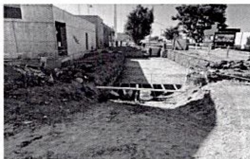
OBRA_10_DGOP-SFIA-AD-PU-EG-2024-126 Primera etapa para la construcción del Complejo de Seguridad Ciudadana en Irapuato, Guanajuato.
