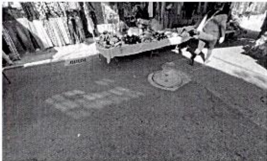
OBRA_39_JAPAMI-AD-RP-OP-2025-16 Rehabilitación por Colapso Sanitario de la calle Pirul, del tramo de Presidencia de la Republica a calle Poder Ejecutivo.
