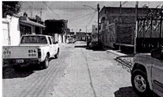
OBRA_40_JAPAMI-AD-PR-OP-2025-17 Acciones para atender contingencia en calle Granada, colonia Bernardo Cobos (tramo de calle Coruña a calle Gerona).
