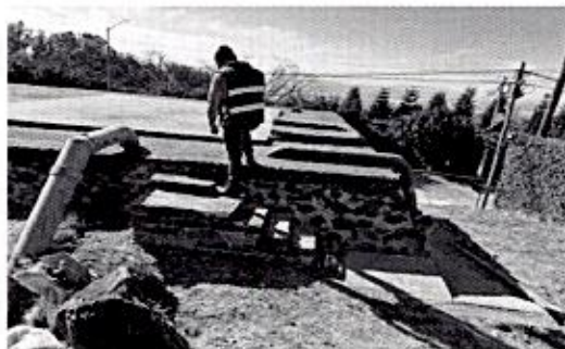
OBRA_36_JAPAMI-LPN-PRODDER-2025-025 Equipamiento de sistemas de bombeo en pozos en Villas de Irapuato.
