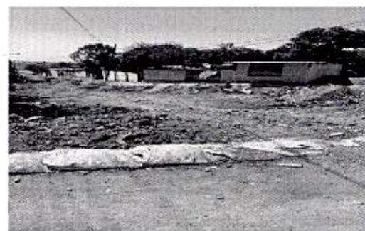
OBRA_6_DGOP-SENCO-LS-PU-SE-2025-072 Construcción de pavimento con asfalto en el Municipio de Irapuato, Gto., en la localidad Cuchicuato en la calle Independencia (tramo: de calle Av. 5 de Mayo a Lázaro Cárdenas).
