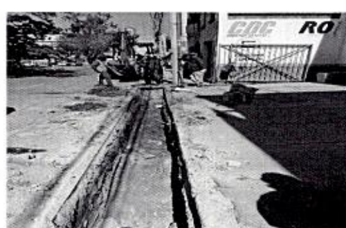
OBRA_30_JAPAMI-LPN-PROAGUA-2025-024 Rehabilitación de red de agua entubada en el municipio de Irapuato, Gto., Fracc. San Pedro (Etapa 2 de 3).
