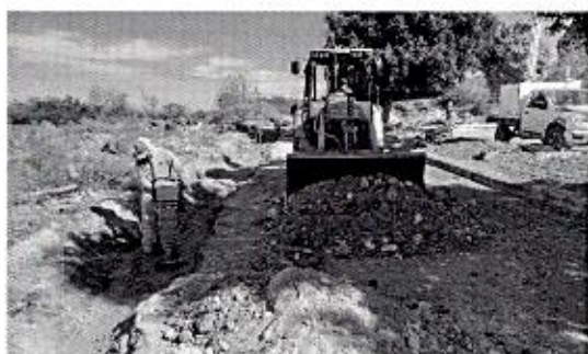
OBRA_35_JAPAMI-LPN-PRODDER-2025-42 Rehabilitación de redes de agua potable para la zona de Villas de Irapuato (1era. Etapa).
