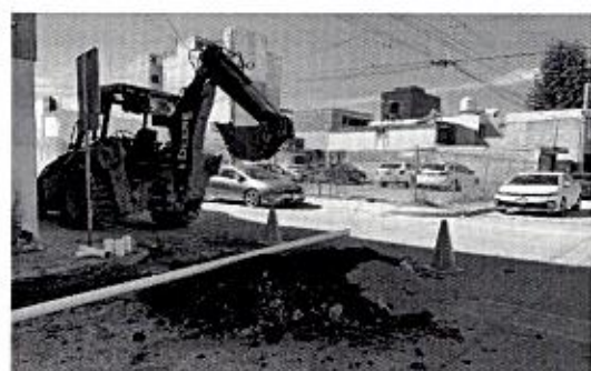
OBRA_29_JAPAMI-LPN-PROAGUA-2025-27 Rehabilitación de red de agua entubada en el municipio de Irapuato, Gto., localidad Irapuato, en la colonia Las Reynas (etapa 2 de 3).
