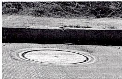
OBRA_44_JAPAMI-AD-PR-OP-2025-05 Construcción de Infraestructura menor (brocales, tapas, bocas de tormenta).
