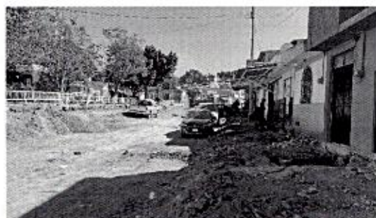
OBRA_26_DGOP-SENCO-LS-PU-SE-2025-070 Construcción de Pavimentación de concreto en el municipio de Irapuato, Gto., localidad San Roque, calle Emiliano Zapata (tramo: de Manuel Doblado al arroyo).
