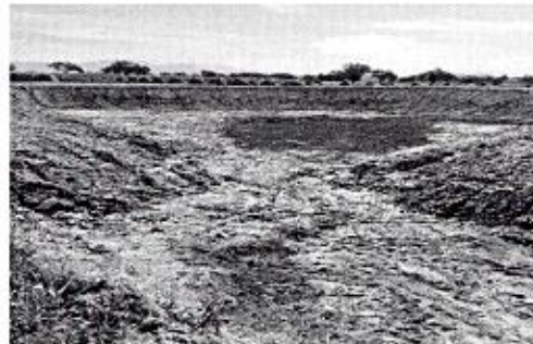
OBRA_28_DGOP-FIBIR-AD-PU-TG-2025-053 Construcción, rehabilitación, desazolve y ampliación de obras de bordería en diversas comunidades del municipio de Irapuato, Gto.
