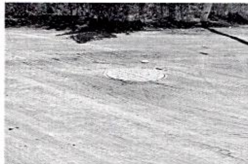
OBRA_42_JAPAMI-AD-RP-OP-2025-29 Construcción de Red de Drenaje Sanitario en la calle Guyana, Col. Ampliación Las Américas.
