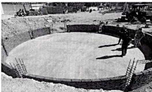
OBRA_21_DGOP-ISM-ADE-PU-SD-2025-071 Construcción de Plaza Pública en la Comunidad de Valencianita, en Irapuato, Gto.
