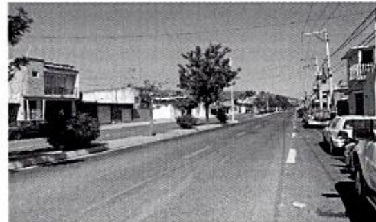
OBRA_16_DGOP-ISM-LPN-PU-SI-2025-047 Rehabilitación vial de la calle Santo Domingo tramo: Av. Héroe de Nacozari a calle División del Norte, Col. Las Heras en el Municipio de Irapuato, Gto.
