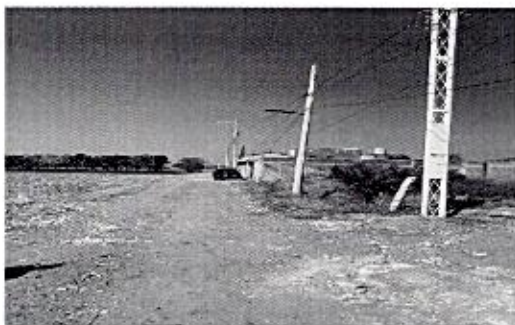
OBRA_5_DGOP-SENCO-AD-PU-SG-2025-057 Ampliación de red de electrificación en el municipio de Irapuato, Gto., en la localidad San Cristóbal en la calle Prologación Altamirano.
