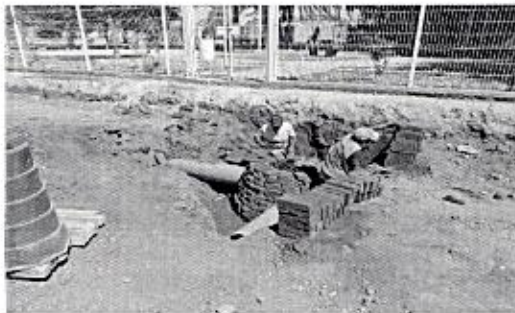
OBRA_15_DGOP-SENCO-AD-PU-SE-2025-069 Construcción de pavimentación con concreto hidráulico en el municipio de Irapuato, Gto., en la localidad Irapuato, en la colonia Plan Viviré, en la calle 3 de abril (tramo: de Lázaro Cárdenas a Av. Independencia).
