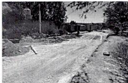
OBRA_22_DGOP-SENCO-LS-PU-SE-2025-075 Construcción de pavimentación con asfalto en el municipio de Irapuato, Gto., en la localidad de Tejamanil en la calle Deportiva (mezquite) tramo: Palma a camino de la carretera.
