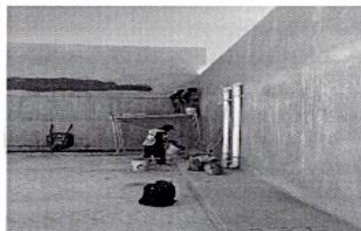
OBRA_24_DGOP-ISM-ADE-PU-EG-2025-048 Rehabilitación del centro de Desarrollo Comunitario en la colonia 18 de Agosto, en Irapuato, Gto.
