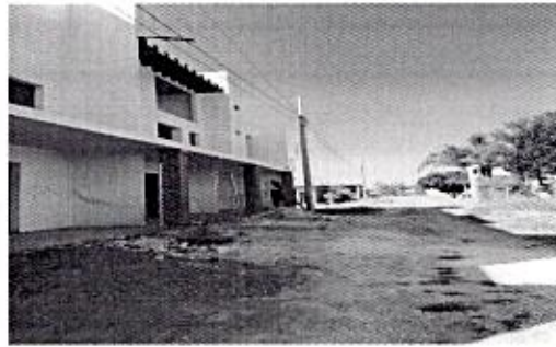
OBRA_2_DGOP-SENCO-AD-PU-SG-2024-058 Ampliación de red de electrificación en el municipio de Irapuato, Gto., en la localidad San Cristóbal, en la calle Privada Paraíso.
