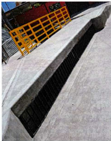
CONSTRUCCIÓN DE ALCANTARILLA PLUVIAL EN LA CALLE MANZANO DE LA COMUNIDAD EL COPAL.
