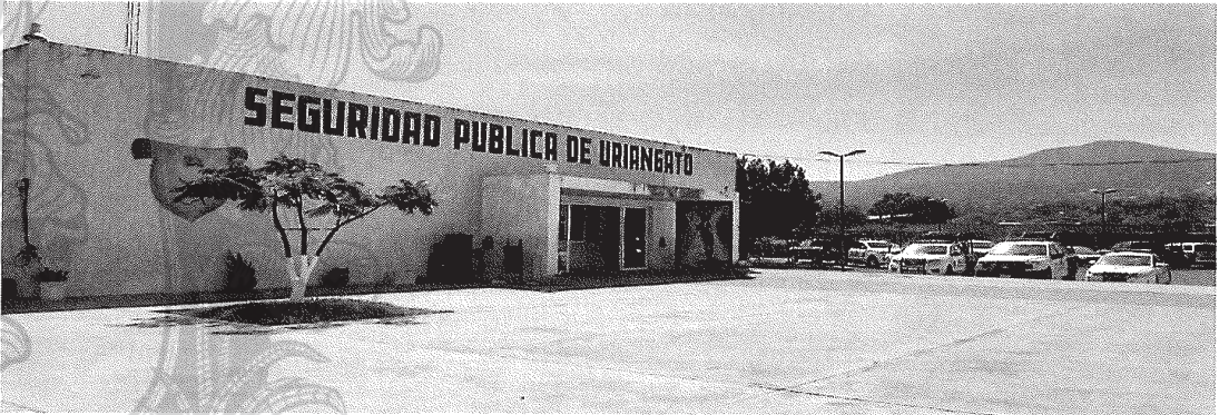
(Instalaciones de seguridad pública municipal Uriangato)
