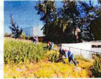
Imagen 11. Mantenimiento a zona de techo verde.
