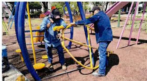
Fotografía 23. Mantenimiento mayor Col. La Pradera 04 de Junio 2025
