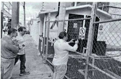
Obra_5_JAPAMI-LE-RP-LS-2025-003 Rehabilitación de pozos profundos de agua potable en el municipio de Irapuato, Gto. (Distrito 2) (Incluye aforo) (2025) Gto. Visita al Sitio
