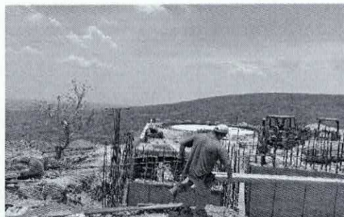
OBRA_4_JAPAMI/LPN/RP/2024-29 Construcción de Tanque de Vidrio Fusionado al acero en la Zona Alta de Villas de Irapuato.
