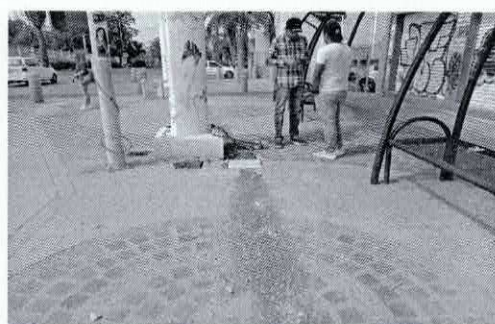
OBRA_8_DGOP-FFM-AD-PU-5D-2025-010 Iluminación escénica de puente peatonal "CBTIS" en Irapuato, Gto.
