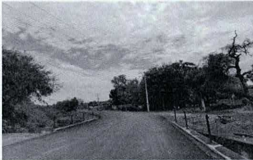
OBRA_11_DGOP-ISM-LPN-PU-UB-2024-157 Construcción de comunidad rural en el tramo del entronque a la comunidad lo de Sierra Km. 3+400.00 al acceso a la comunidad Santa Rosa Temascatio Km. 11+463.00 del municipio de Irapuato, Gto..
