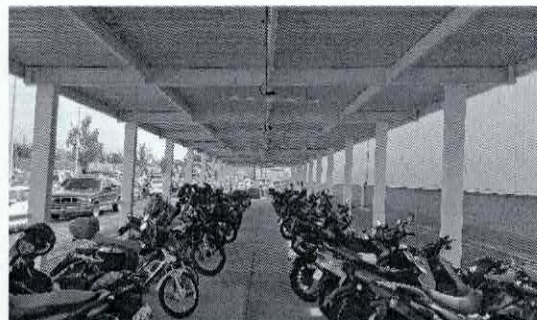
OBRA_10_DGOP-RM-AD-PU-5D-2024-145 Trabajos de Restitución de Fachadas y obras complementarias, por afectaciones de la obra del Paso Superior de Línea "A" de Ferromex con cruce con Calzada de Guadalupe, en Irapuato, Gto. (Paquete 6).
