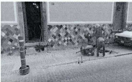
OBRA_5_DGOP-RM-AD-PU-5D-2025-004 Conservación Rutinarias y Mejoramiento de Infraestructura y Equipamiento del Centro Histórico en Irapuato, Gto.
