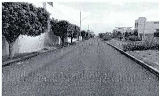
OBRA_9_DGOP-FFM-AD-PU-SE-2023-030 Mantenimiento Vial de la Av. Paseo Irapuato, cuerpos oriente y poniente, tramo: de calle Florencia a Héroes de Nacozari, en el fraccionamiento Residencial Campestre, en el municipio de Irapuato, Gto.
