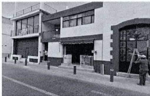
OBRA_15_DGOP-FFM-AD-PU-5D-2025-007 Rehabilitación de fachadas en calle Pípila de Zona Centro.
