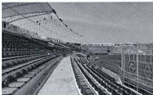
OBRA_3_DGOP-RM-LPN-PU-EG-2024-003 Proyecto integral para la instalación eléctrica, alumbrado de cancha y obra complementaria, en el Estadio Sergio León Chávez; en Irapuato, Gto.
