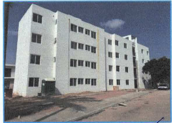
Foto 02. Fachada Norte Fecha: 27.jun.25
