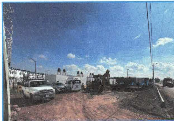
Foto 08. Construcción de cárcamo pluvial. Fecha: 27.jun.25
