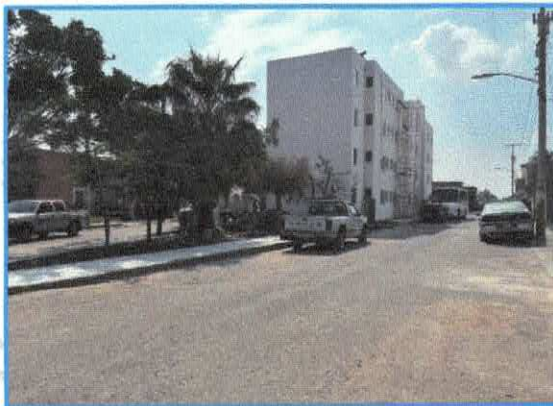
Foto 01. Fachada Sur. Fecha: 27.jun.25
