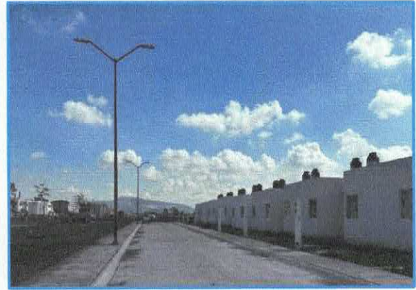
Foto 07. Viviendas dúplex sobre calle Arrayán. Fecha: 27.jun.25
