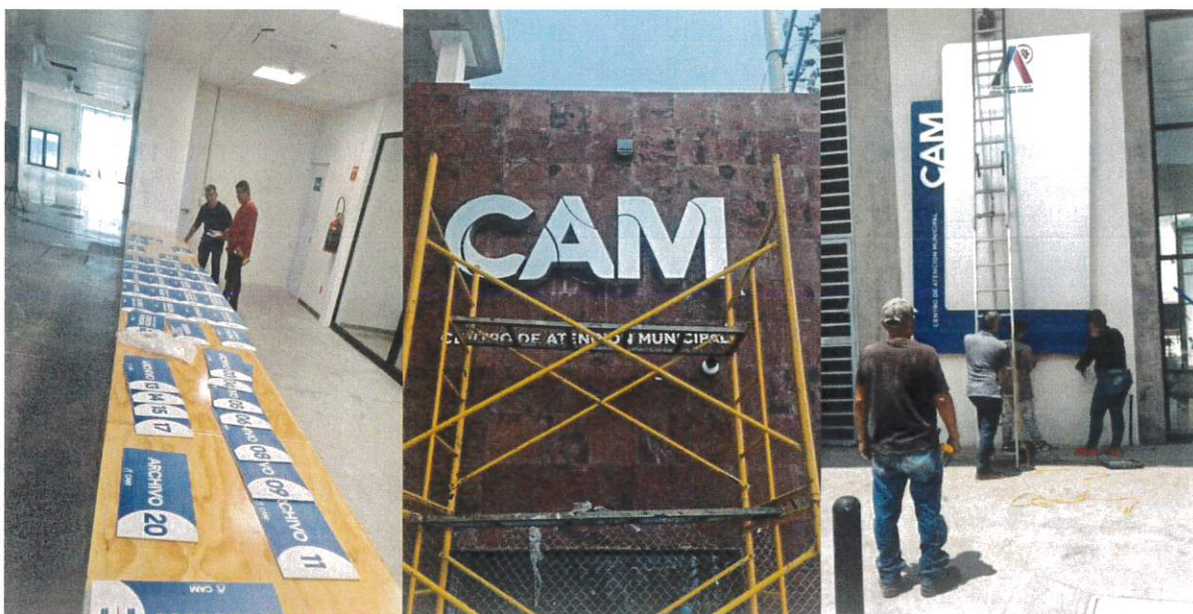
ILUSTRACIÓN 3. SUPERVISIÓN A LA COLOCACIÓN DE SEÑALÉTICA 9, 23 Y 26 DE JUNIO 2025
