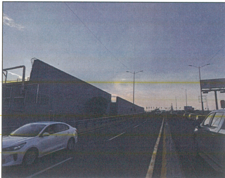
MANTENIMIENTO VIAL DE LA CALLE GUERRERO, TRAMO: 5TA. AVENIDA A PRIV. GUERRERO, (PUENTE SIGLO XXI)
