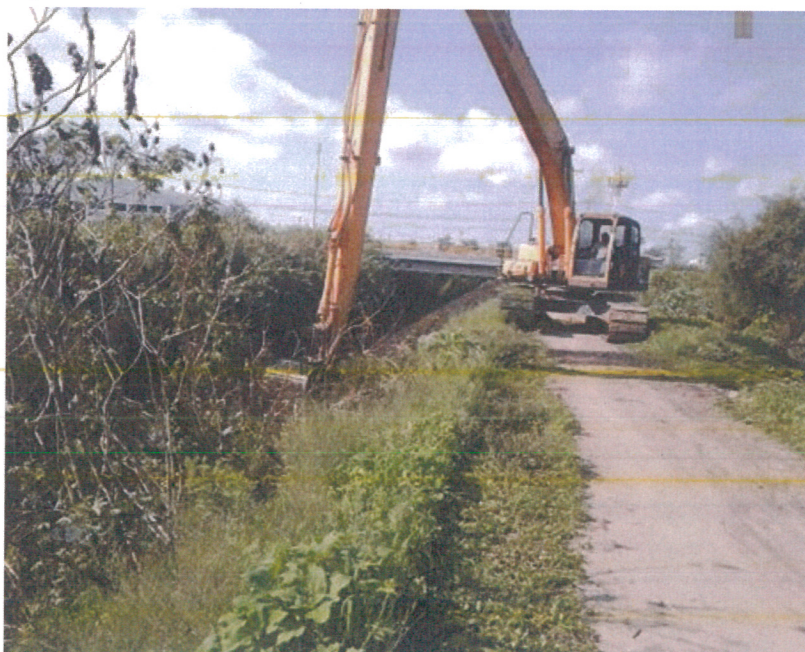
TRABAJOS DE LIMPIEZA Y DESAZOLVE DEL RÍO GUANAJUATO CON MÁQUINA EN SU TRAMO DE CALLE TERESA VARA A 100 MTS AGUAS ABAJO DEL PUENTE DE RESIDENCIAL FLORESTA
