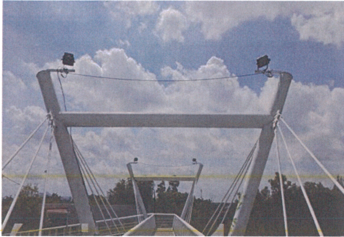
ILUMINACIÓN ESCÉNICA DE PUENTE PEATONAL "CBTIS"
