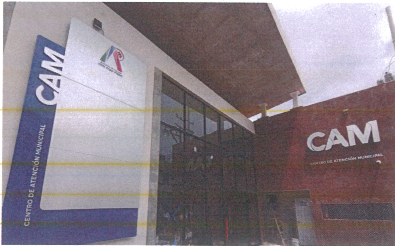
CONSTRUCCIÓN DEL CENTRO DE ATENCIÓN MUNICIPAL (CAM)
