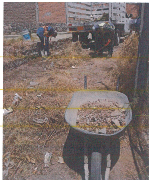
CONSTRUCCIÓN DE ALCANTARILLA PLUVIAL EN LA CALLE MANZANO DE LA COMUNIDAD EL COPAL
