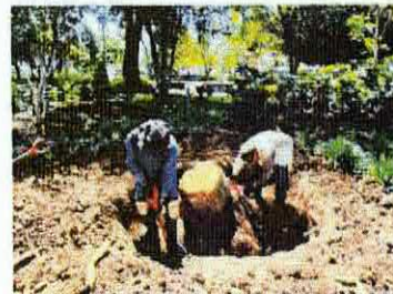
Imagen 6. Extracción de tocón.
