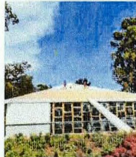
Imagen 38. Limpieza techo CEA.
