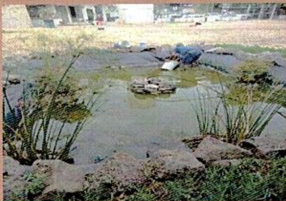
Limpieza de biolago
