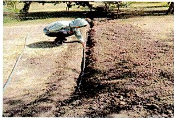
Colocación de manguera para riego en periferia de cancha de fútbol uruguayo
