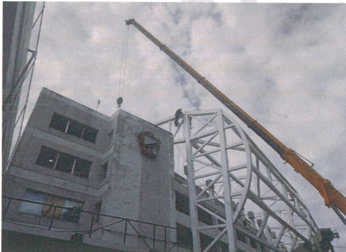
Proyecto Integral para la construcción de Cubierta norte, Fachada y Obra Complementaria, en El Estadio Sergio León Chávez.
