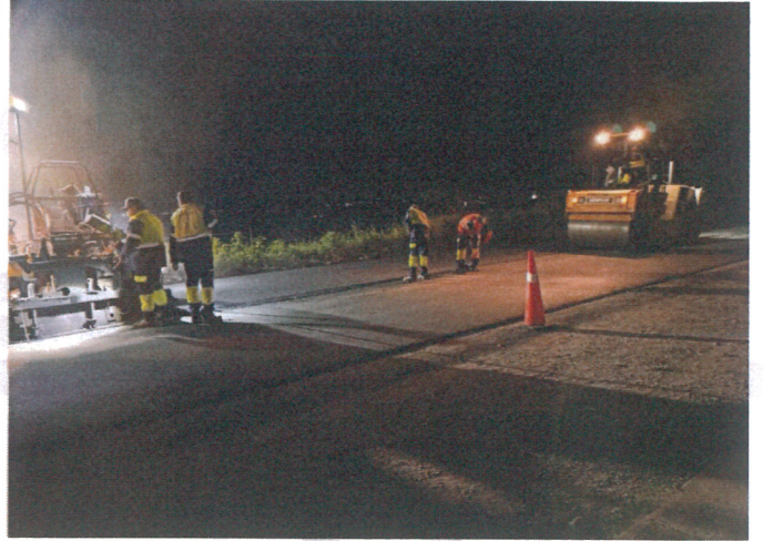
Mantenimiento mayor de Carretera Irapuato-San Cristóbal.
