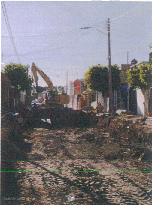
Construcción de pavimento con concreto, en la Colonia la Hacienda, calle Colombia .
