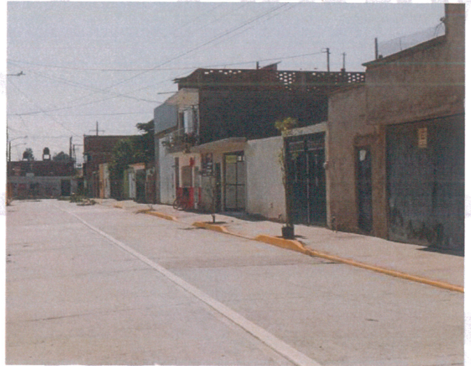
Construcción de Calle con Concreto, en la Colonia Granjas Agropecuarias San Miguel, Calle Halcón.
