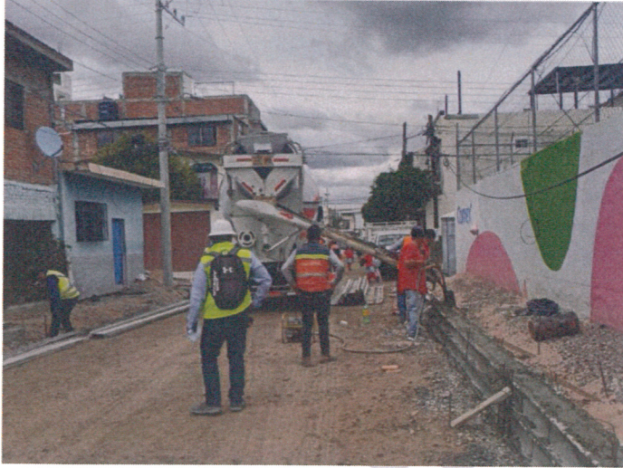
Construcción de pavimento con concreto en la Colonia Esfuerzo Obrero, calle Derechos y Deberes.
