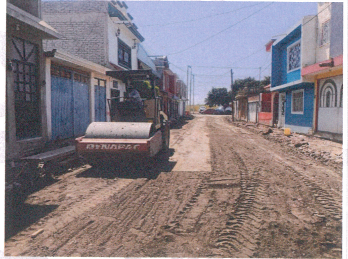
Construcción de pavimento con concreto en la Colonia San Martín de Porres, calle San Nicolás.
