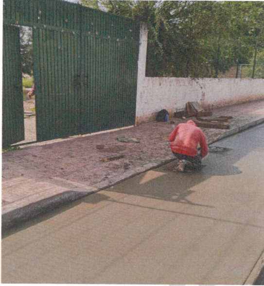
Construcción de Calle con Concreto Localidad Providencia de Pérez (El Guantón), Calle Guanajuato – Girasol.
