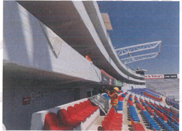
Proyecto Integral para la Rehabilitación de palcos norte, sur y obra complementaria, en el Estadio Sergio León Chávez.
