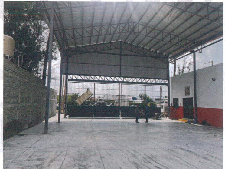
Rehabilitación de las instalaciones de la estación uno de bomberos,
