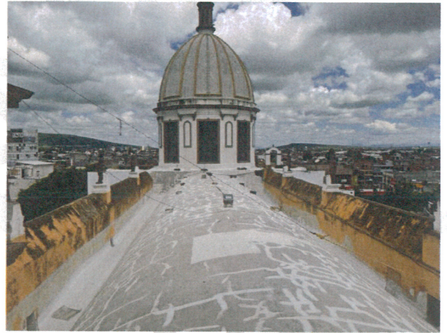
Mantenimiento y consolidación de grietas en el Templo de Catedral .
