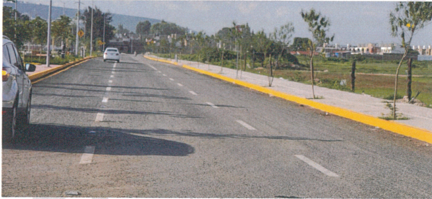
Construcción de la Av. Gabriel García Márquez en el Tramo: de la Av. Gerardo Murillo a Calle Girasol
