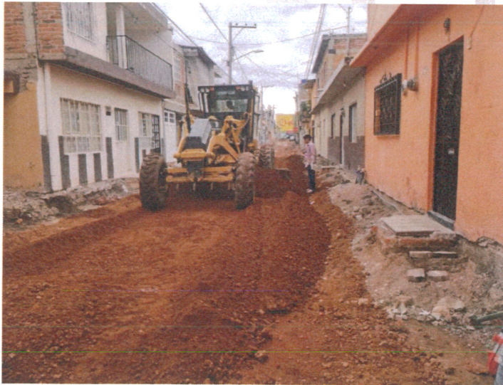
Construcción de pavimento, en la Colonia Municipio Libre, calle Poder Ejecutivo.
