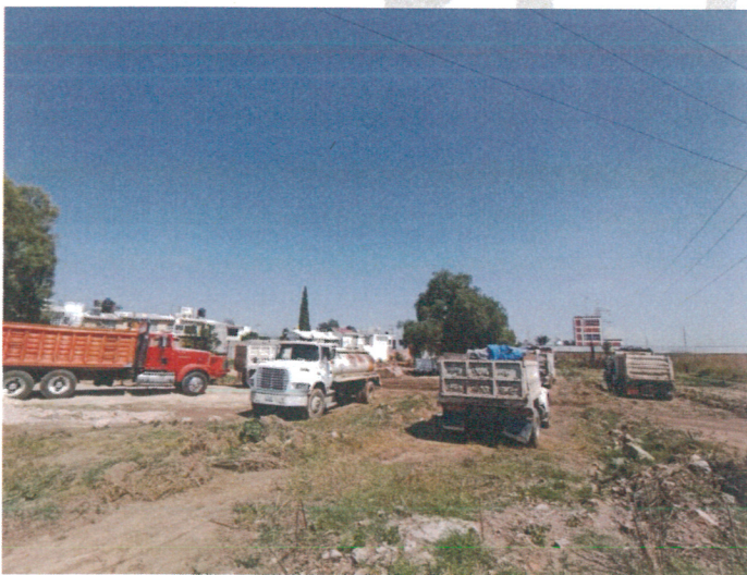
Construcción de Centro Regional de gestión de residuos CREA-GTO-BIOMASA .
