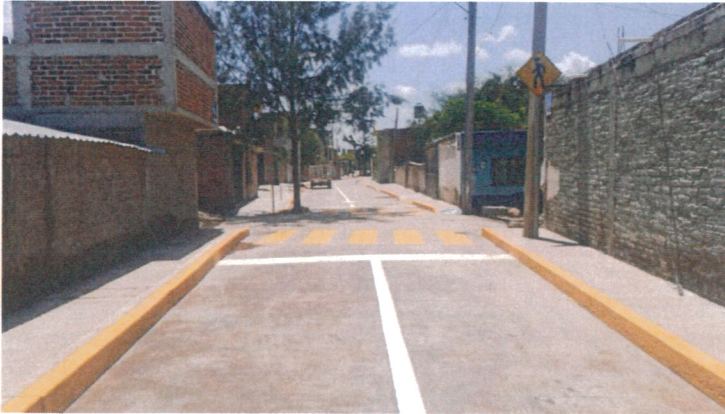
Construcción de Calle con Concreto, Localidad de Tomelopitos, Calle Morelos .
