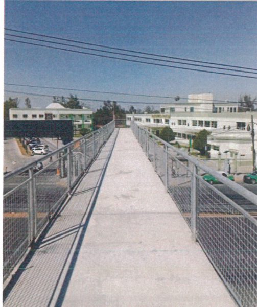
Reforzamiento de puente peatonal Av. Solidaridad-Zona Militar.
