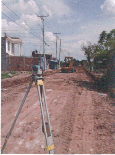
Adecuación de circuito de acceso alternativo al Blvd. Villas de Irapuato.
