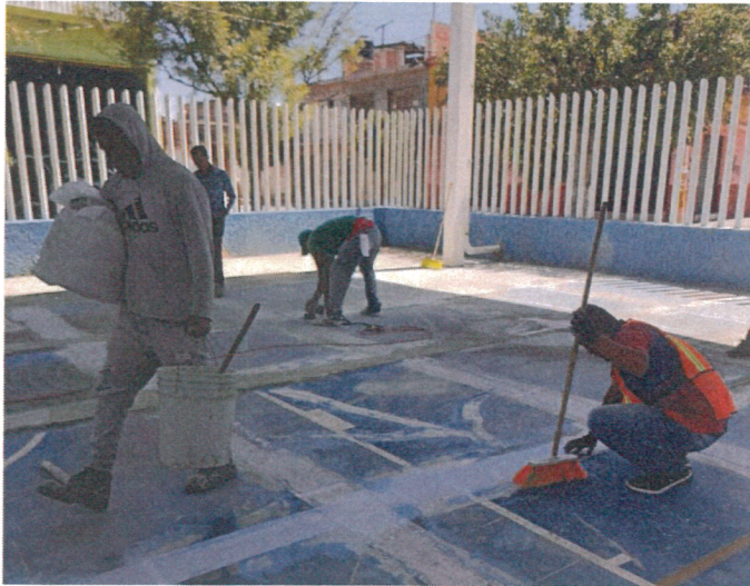
Rehabilitación de centro de desarrollo comunitario colonia San Juan de Retana.
