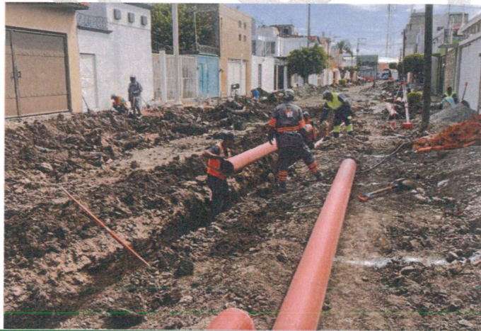
Construcción de pavimento con concreto, en la Colonia la Moderna, calle Eduardo M. Vargas.
