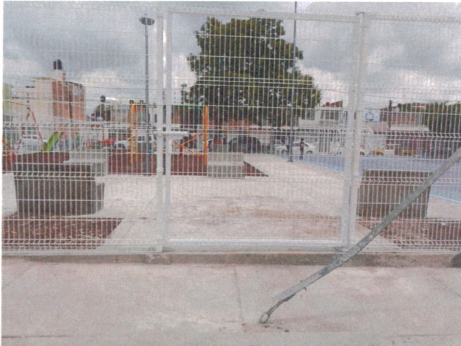
Construcción de parque público en la colonia Bernardo Cobos .
