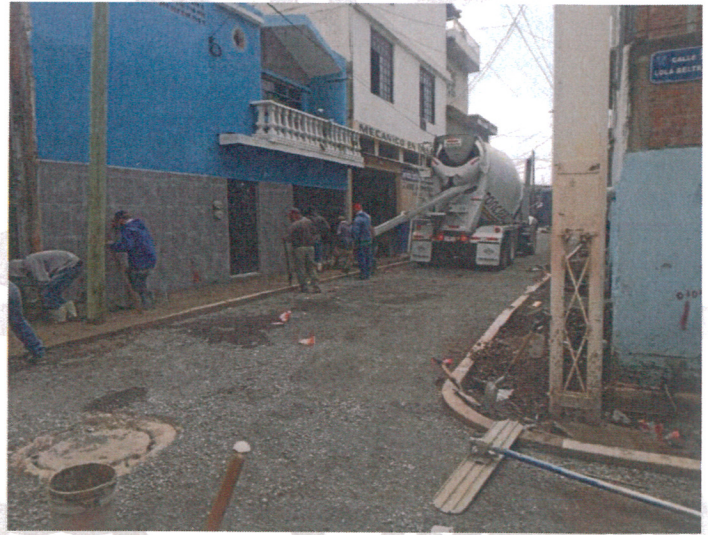
Construcción de pavimento con asfalto, en la Colonia el Pípila, calle Lola Beltrán.
