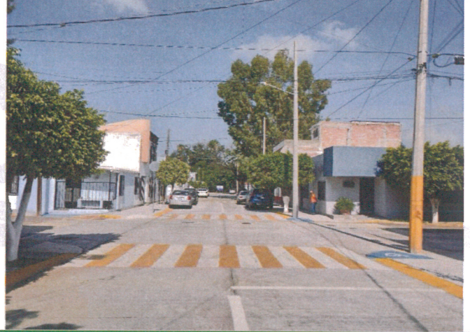
Construcción de Calle con Concreto, en el Fraccionamiento Arboledas, en la Calle Turquesa
