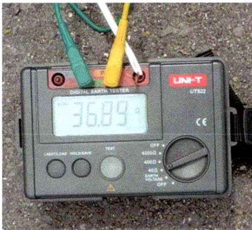
Medicion inicial tierra fisica 1
