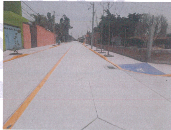
Construcción de Calle con Localidad Purísima del Progreso, Calle Ignacio Zaragoza.
