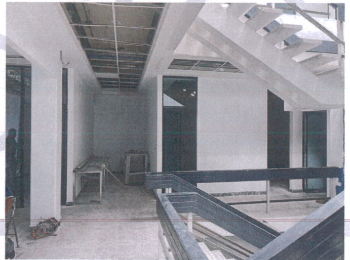
Adecuación y Rehabilitación de las Oficinas del Núcleo Social en el Edificio Cortazar .
