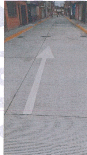
Construcción de Calle con Concreto en la Colonia Flores Magón Norte - Los Príncipes, Calle Jardín de los Príncipes .
