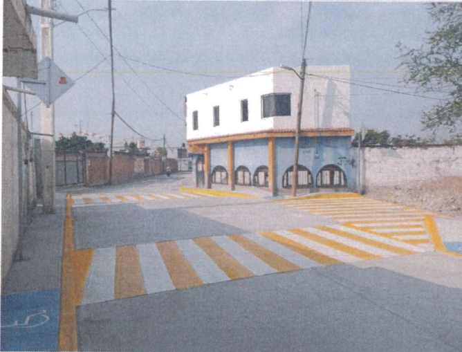
Construcción de Calle con Concreto en la Localidad San Cristóbal, en la Calle Terán .
