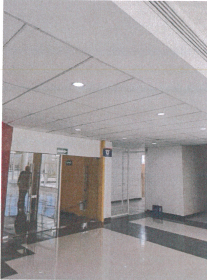
Rehabilitación de baños y plafón de vestíbulo en pabellón 1 y 2 del INFORUM.
