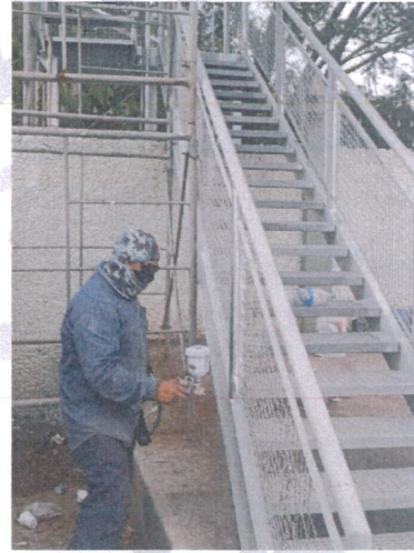
Reforzamiento de puente peatonal Av. Solidaridad-Zona Militar.
