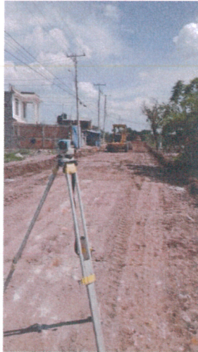
Adecuación de circuito de acceso alternativo al Blvd. Villas de Irapuato.
