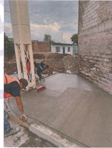
Construcción de calle con concreto en la Localidad la Calera. Calle Felipe Ángeles
