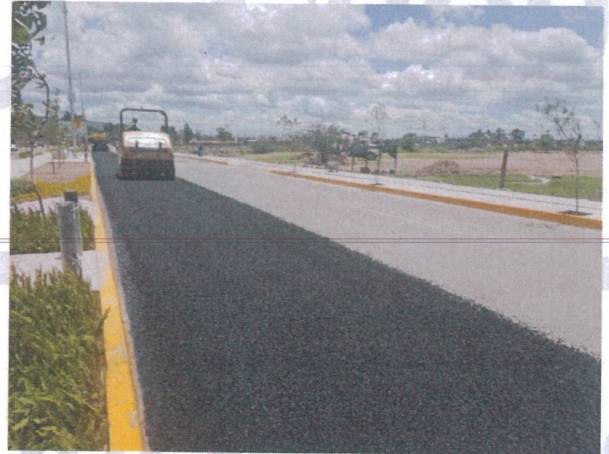
Construcción de la Av. Gabriel García Márquez en el Tramo: de la Av. Gerardo Murillo a Calle Girasol.
