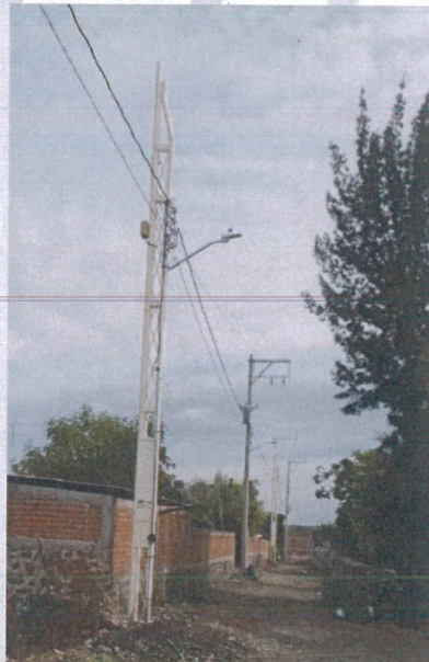
Ampliación de Electrificación en la Localidad de Vista Hermosa III Calle Los Gascas .
